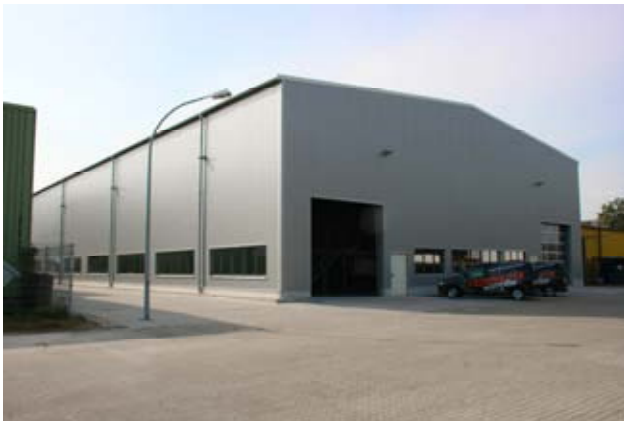
Die neue Logistikhalle der Conductix-Wampfler AG in Weil am Rhein
