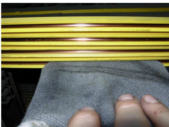
Obrázek 8: Postupně očistěte všechny póly
