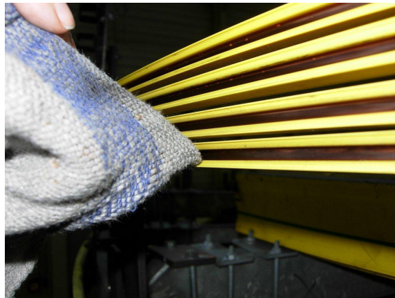
Obrázek 11: Úhel pro čištění spodní plochy
