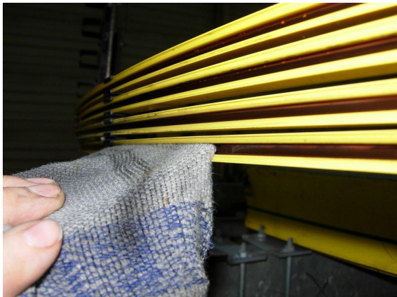
Obrázek 10: Změnou úhlu čisticího nástroje čistíte různé plochy
